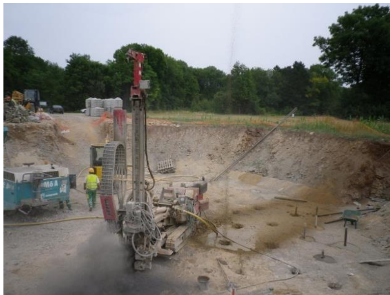
Photographie 3 : Atelier de forage, armement et calage de mortier
