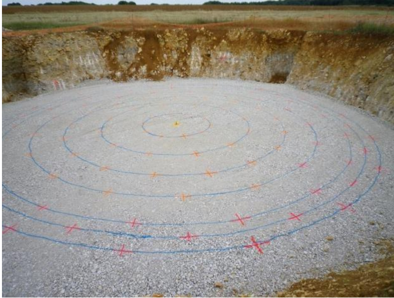
Photographie 2 : Exemple de première couche du matelas avec réalisation du maillage des pieux.
