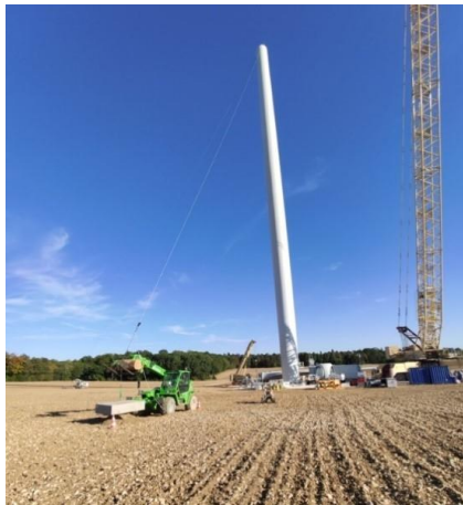
Photographie 4 : Exemple de l'installation de haubans pour stabilisation du mât
